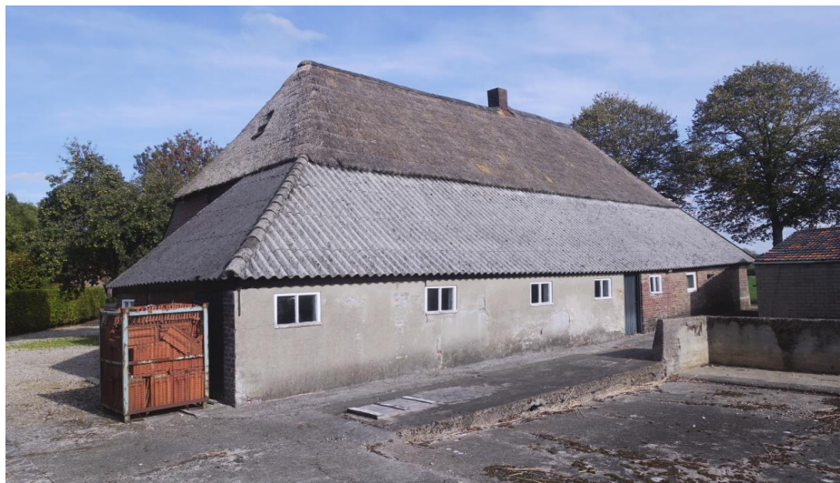
Zicht op de zuidgevel van de boerderij.
