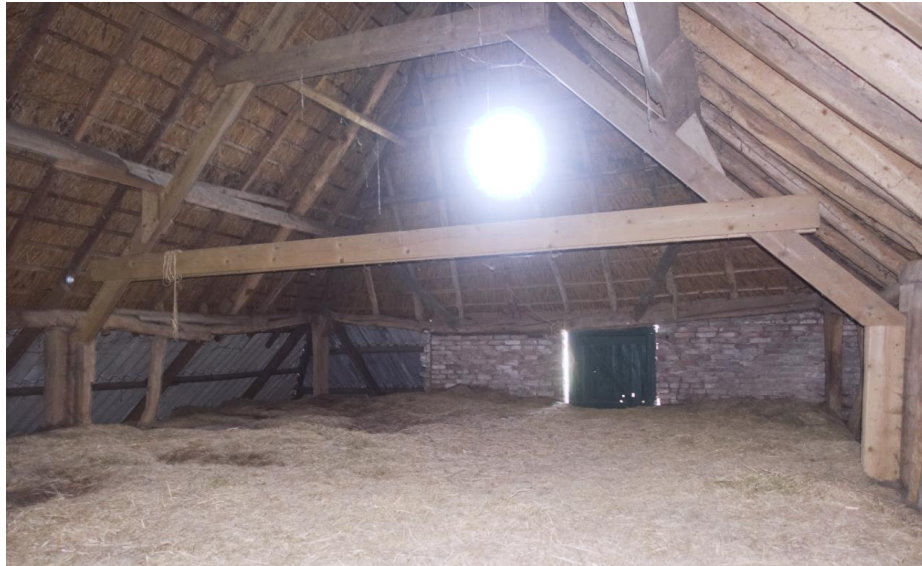
De kap is met spanten vernieuwd in het midden van twintigste eeuw.
