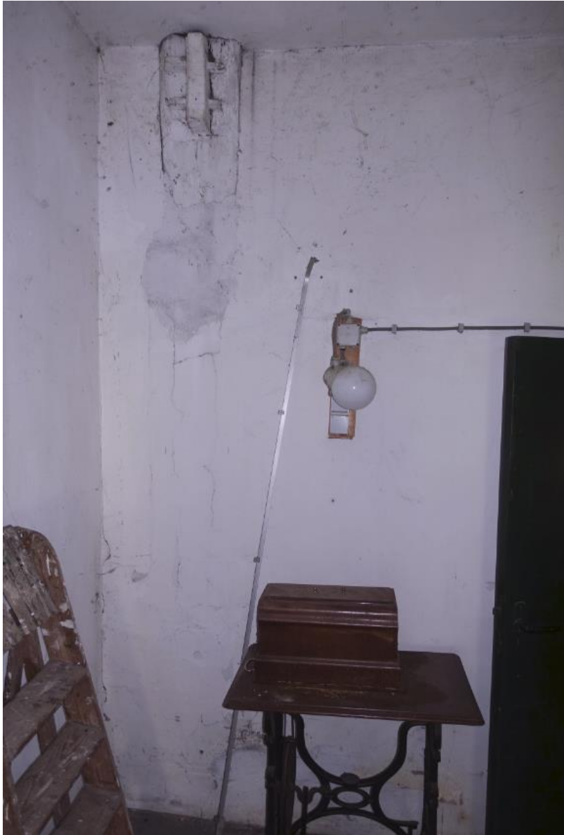
Zicht op het noordelijke gebintstijl in het woongedeelte. Deze stijl is opgenomen in het muurwerk.
