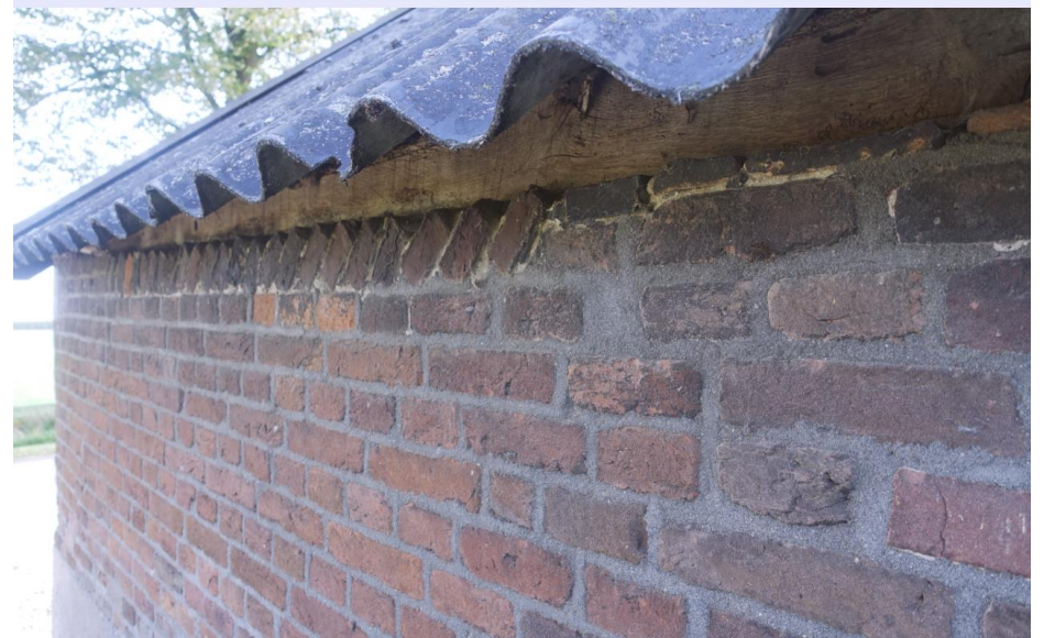
Detail van de oudere muurplaat aan de bovenzijde van de noordelijke zijgevel. Deze plaat behoort tot een oudere constructie dan het oudste muurwerk in deze gevel.
