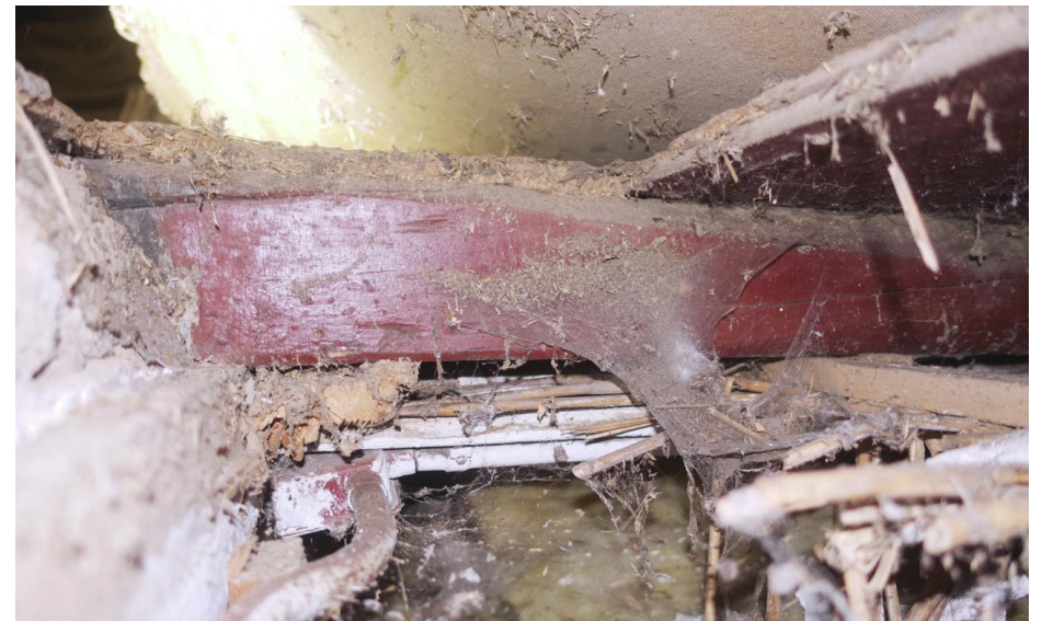
Detail van de rood geschilderde zolderbalklaag boven de noordelijke zijbeuk.
