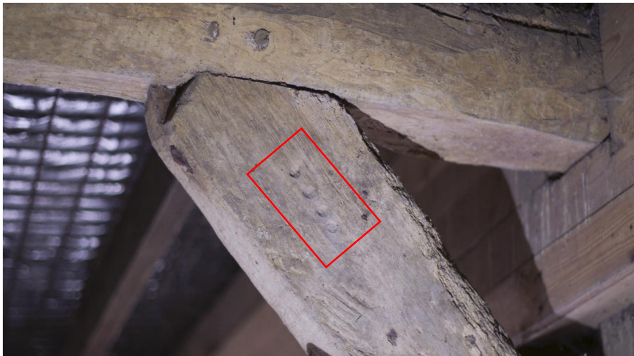
De telmerken op het rechterkorbeel bij het derde gebint. Afb: S. van Hooft 2019.
