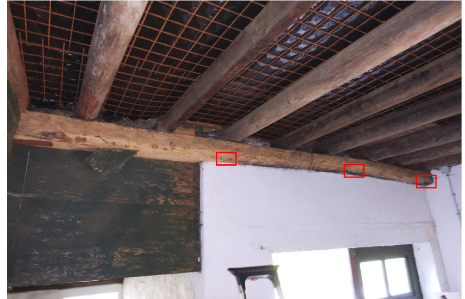
De ankerbalk bij het achterste gebint bezit drie rechte pengaten voor stijlen.
