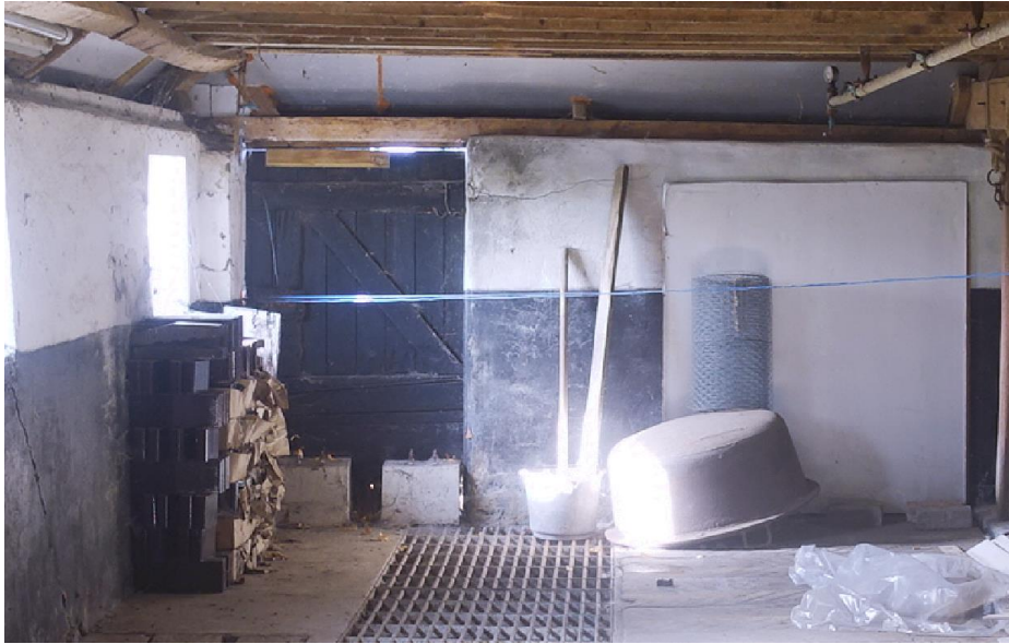
Zicht op de opgeklampte mestdeur in de achtergevel van de uitbouw, gezien van binnenuit.
