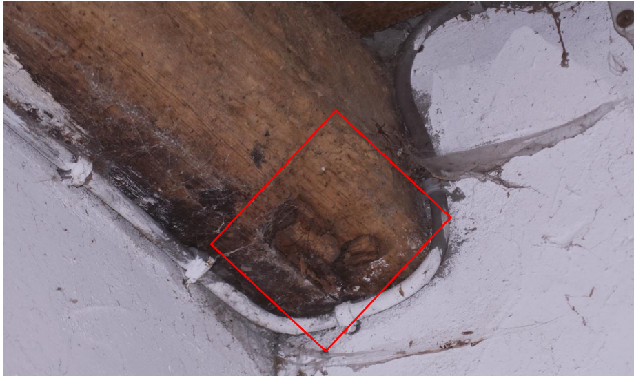
Detail van het meest rechter pengat in de achterste dekbalk waar nog een restant van de stijl in aanwezig is.
