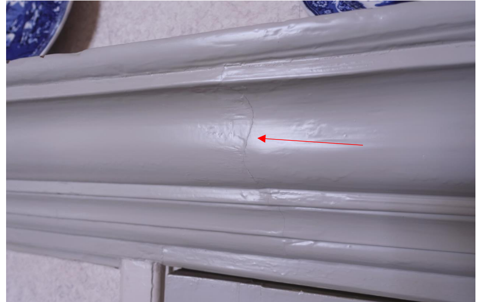
Detail van de laslijn in de boezembalk.
