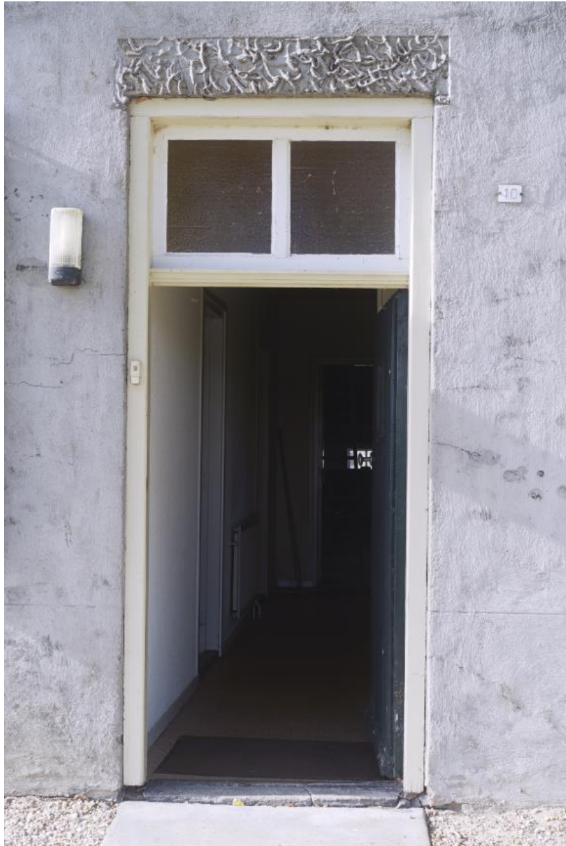
De doorgang is ingezet met een ouder kozijn en jonger bovenlicht.
