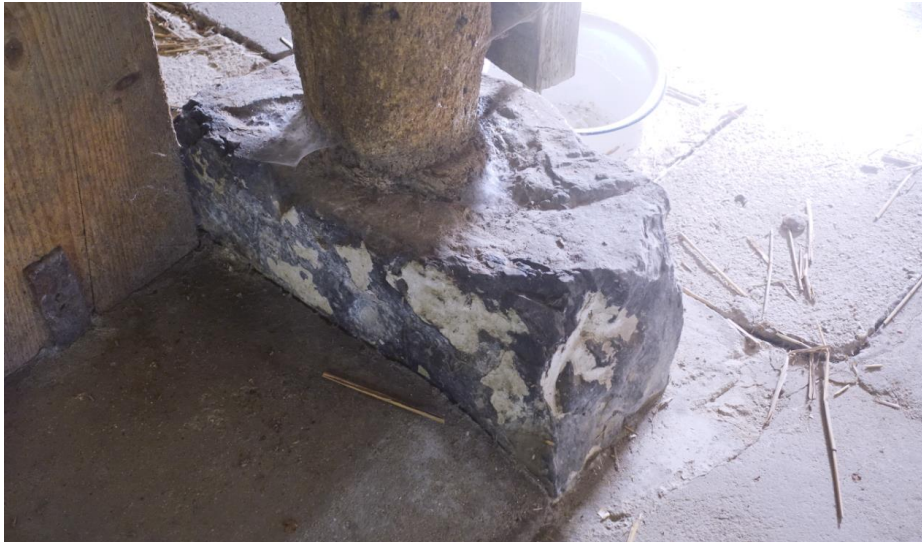
Detail van de hardstenen fundering van de stijlen.
