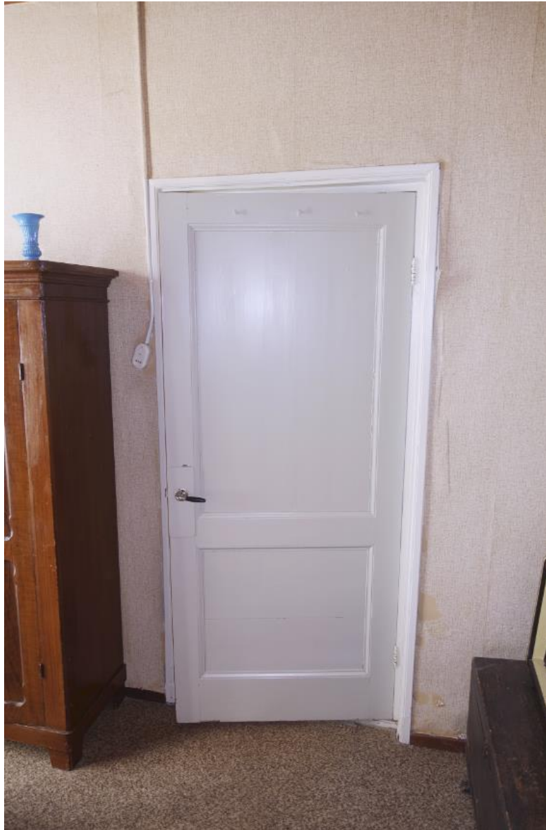
De doorgang tussen de slaapkamer en woonkamer is gevuld met een oude paneeldeur en geprofileerd deurkozijn.
