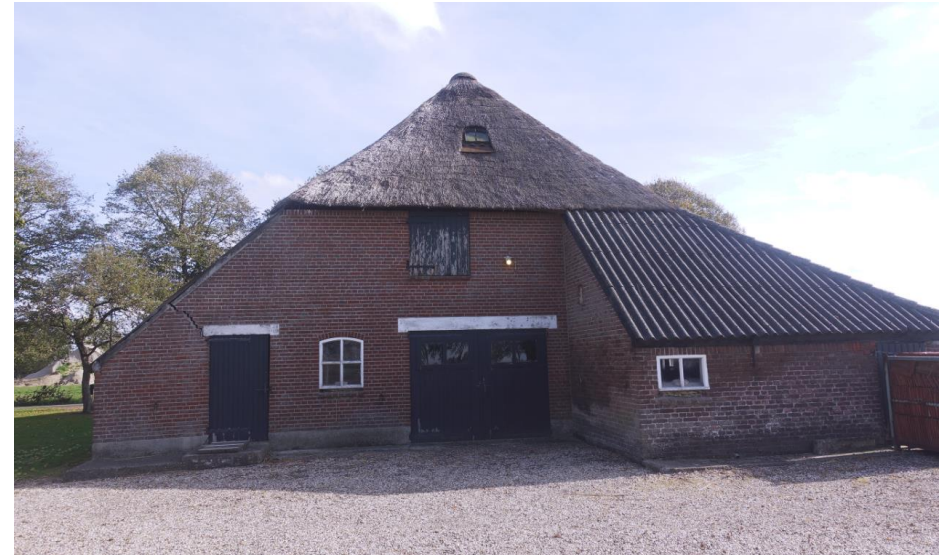
De achtergevel van de boerderij heeft een uitbouw aan de zuidzijde.
