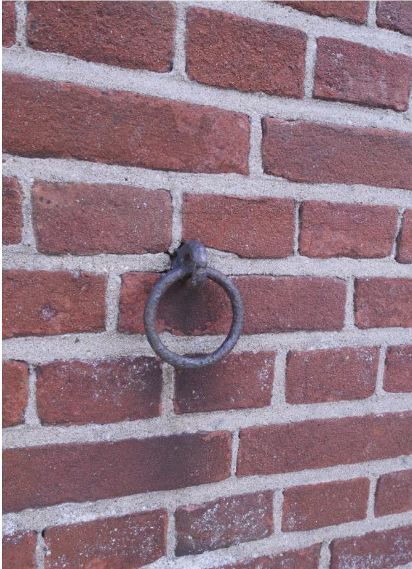
Detail van een ijzeren ring in het muurwerk van de achtergevel.
