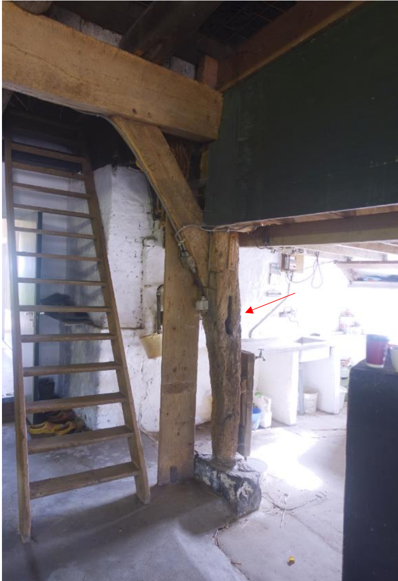
Zicht op de zuidelijke stijl van het eerste gebint in het stalgedeelte. Bij de stijl is een pengat zichtbaar van een verdwenen stalliggerdrager. De stijl is gefundeerd op een blok hardsteen.
