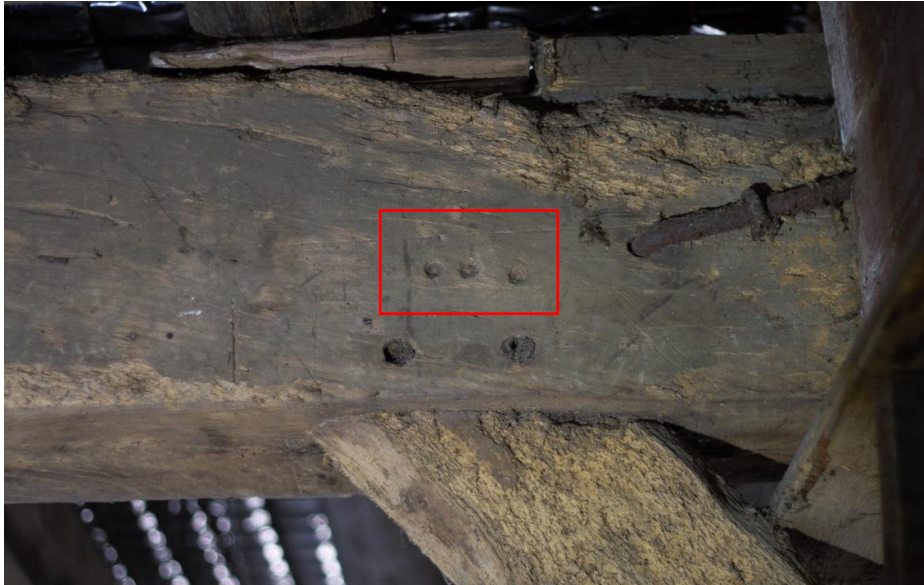
Detail van de telmerken aan de rechterzijde op de ankerbalk van het tweede gebint. Afb: S. van Hooft 2019.
