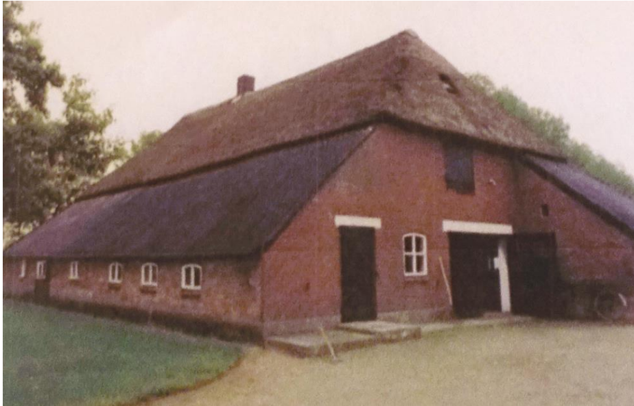
Zicht op de noordgevel en achtergevel. foto: archief eigenaar.
