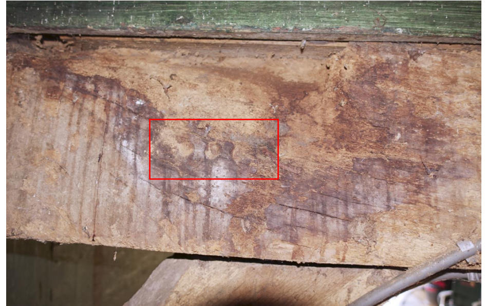
De telmerken aan de linkerzijde op de ankerbalk van het tweede gebint.
