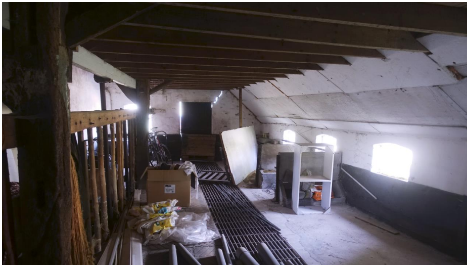
De noordelijke zijbeuk in het stalgedeelte gezien naar de achtergevel.
