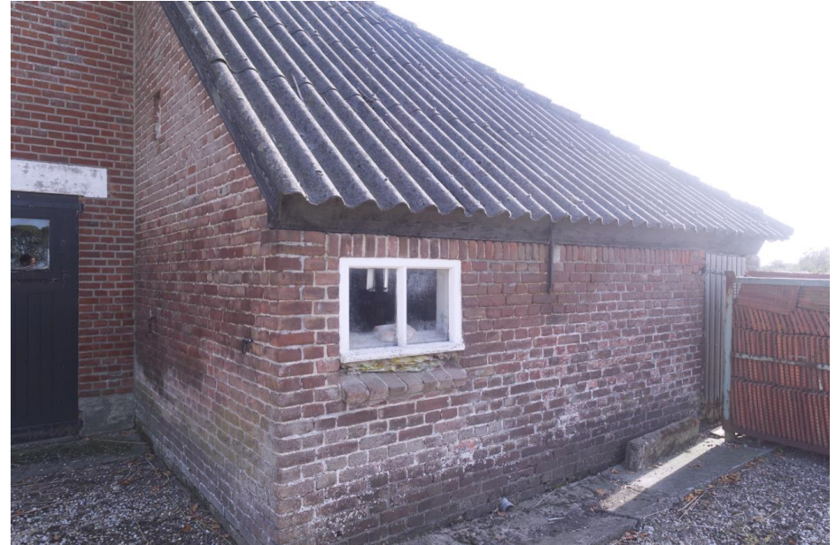
Zicht op het muurwerk van de uitbouw.
