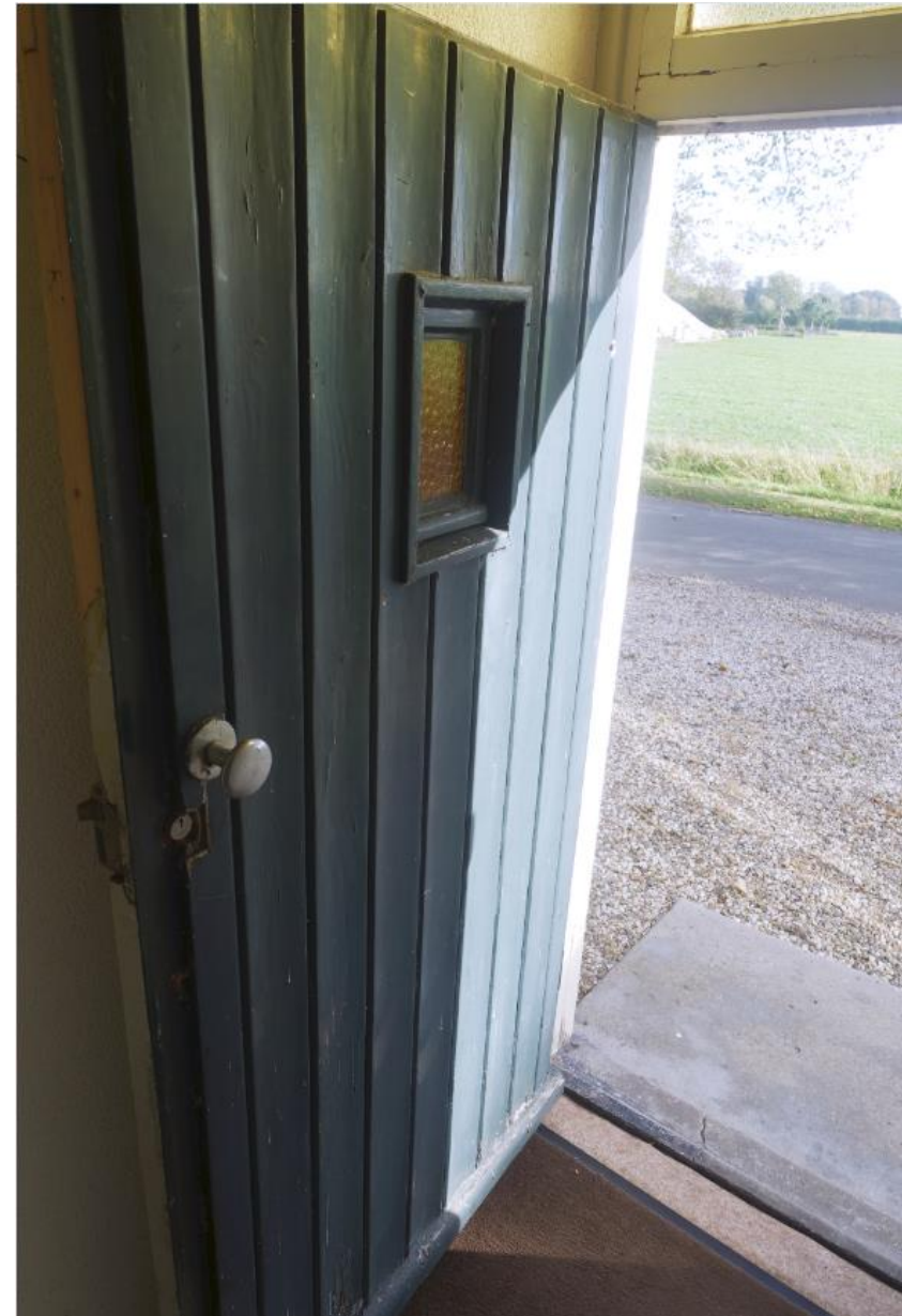
Detail van de opgeklampte voordeur.
