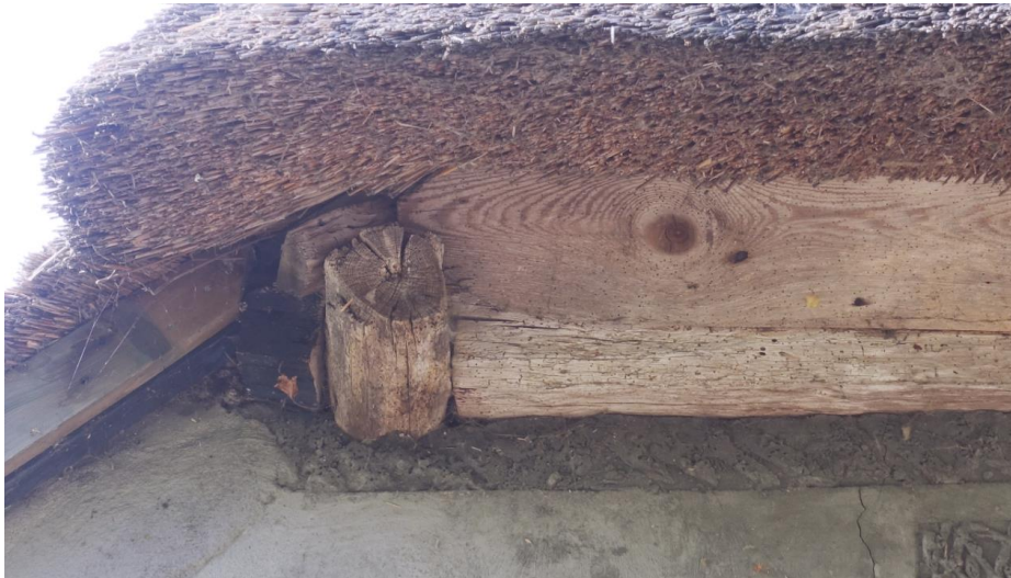
Detail van de doorlopende gebintplaat aan de buitenzijde van de voorgevel, ooit onderdeel van een brede overstek.
