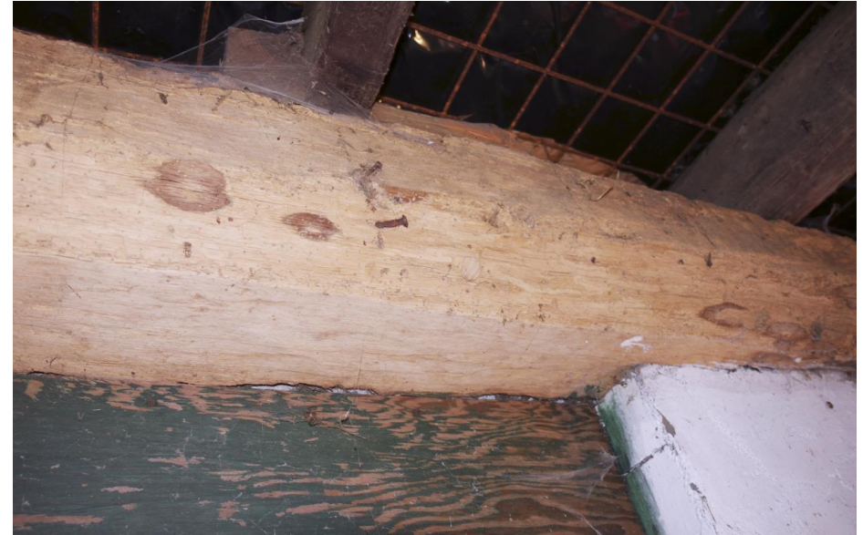
De eikenhouten balk in de achtergevel van het stalgedeelte vormt de ankerbalk van het vierde gebintpaar.
