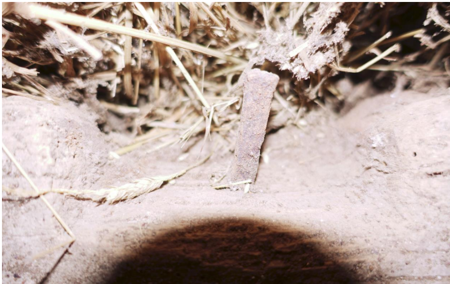
Detail van de keep met ijzeren nagel aan de bovenzijde van de achterste ankerbalk.
