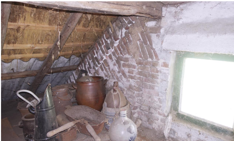
Zicht op het vlechtwerk aan de noordzijde van de voorgevel, gezien vanaf de zolder.
