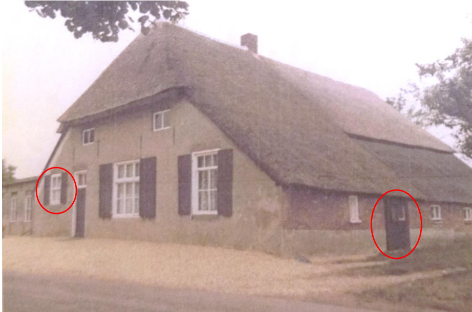
Foto uit 1979 van de bepleisterde voorgevel aan de Langestraat en noordelijke zijgevel met de oude openingen in de rode omlijning. foto: archief eigenaar.
