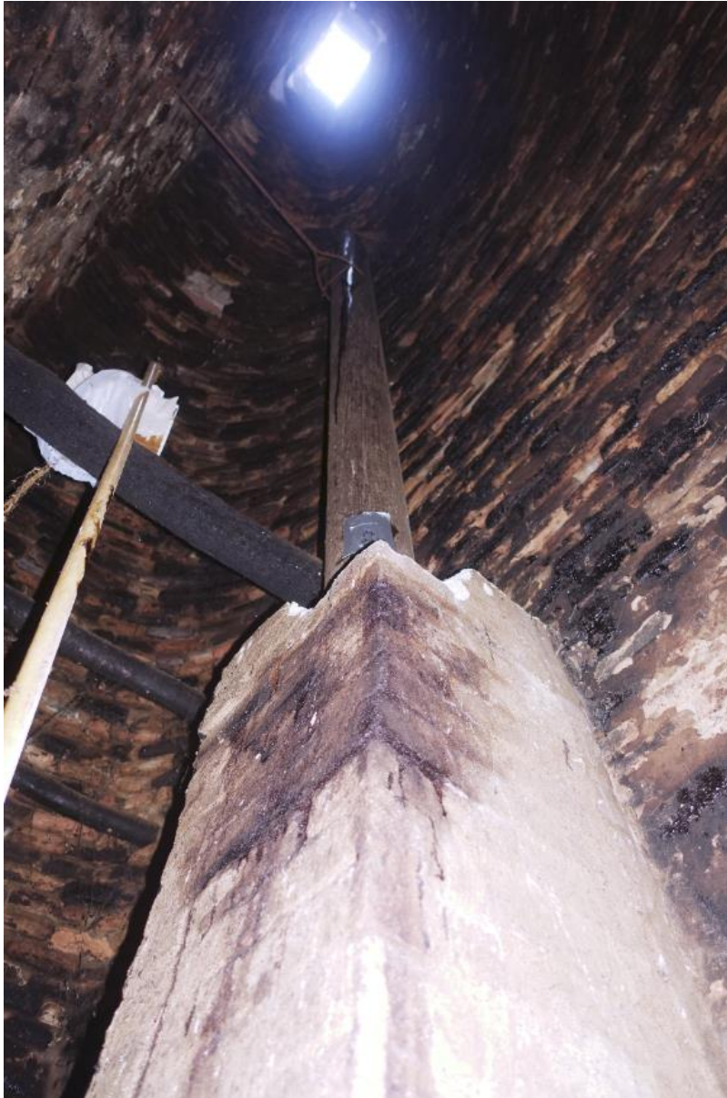
In het oude rookkanaal is in 1950 een nieuw kanaal met pijp opgemetseld met betonstenen.
