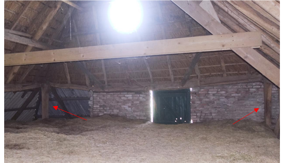
Zicht op de bovenzijde van de gebintconstructie bij het achterste gebint, die aan allebei de zijden nog een oudere stijl heeft (rode pijlen).
