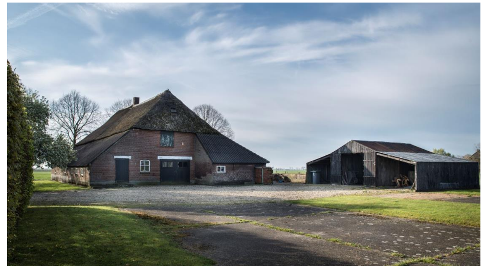
Zicht op het ensemble gezien vanaf het achtererf. afb: funda.nl, makelaar: Agrivesta De Lorijn BV.
