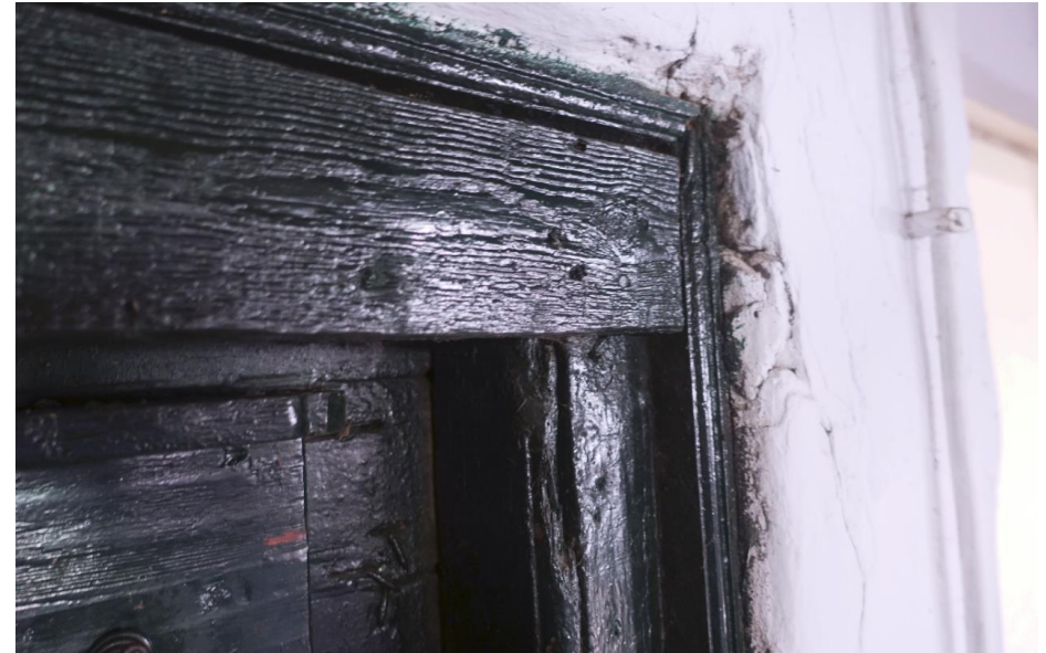
Detail van de profilering van het deurkozijn in de doorgang naar het rookkanaal.
