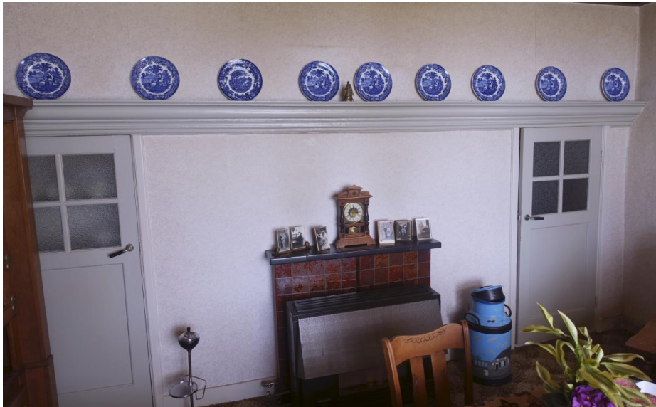
Zicht op de dichtgezette haard aan de achterzijde van de woonkamer.
