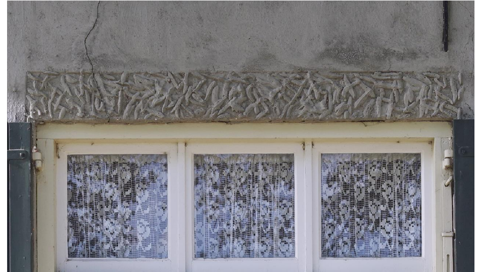
Detail van het pleisterwerk boven de vensteropeningen in de voorgevel.
