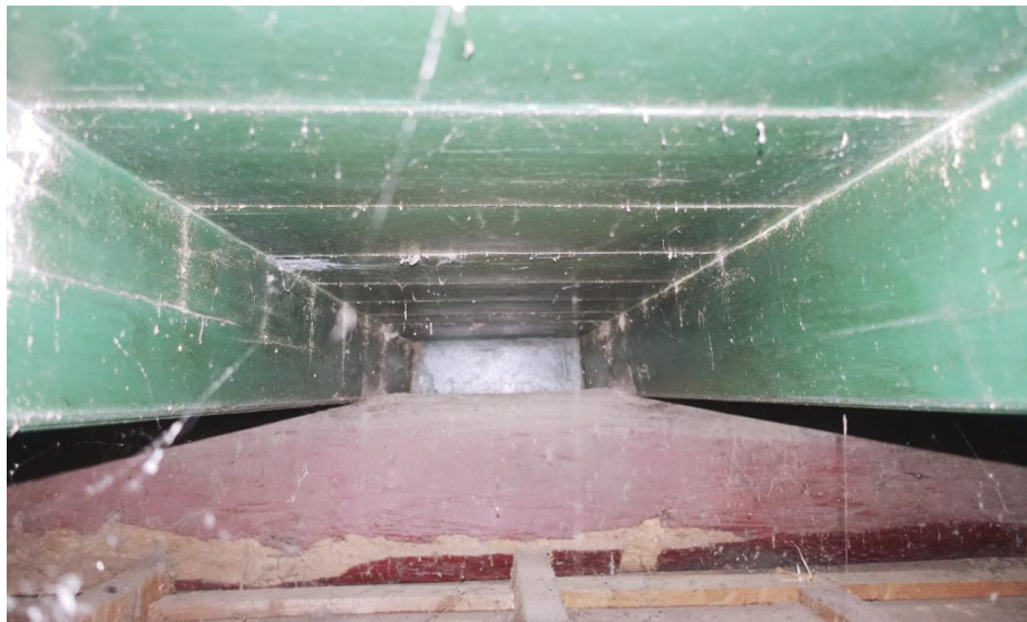
Zicht op de enkelvoudige balklaag van de zoldervloer boven de middenbeuk van het woongedeelte. De rode onderslag is de ankerbalk van het gebint.
