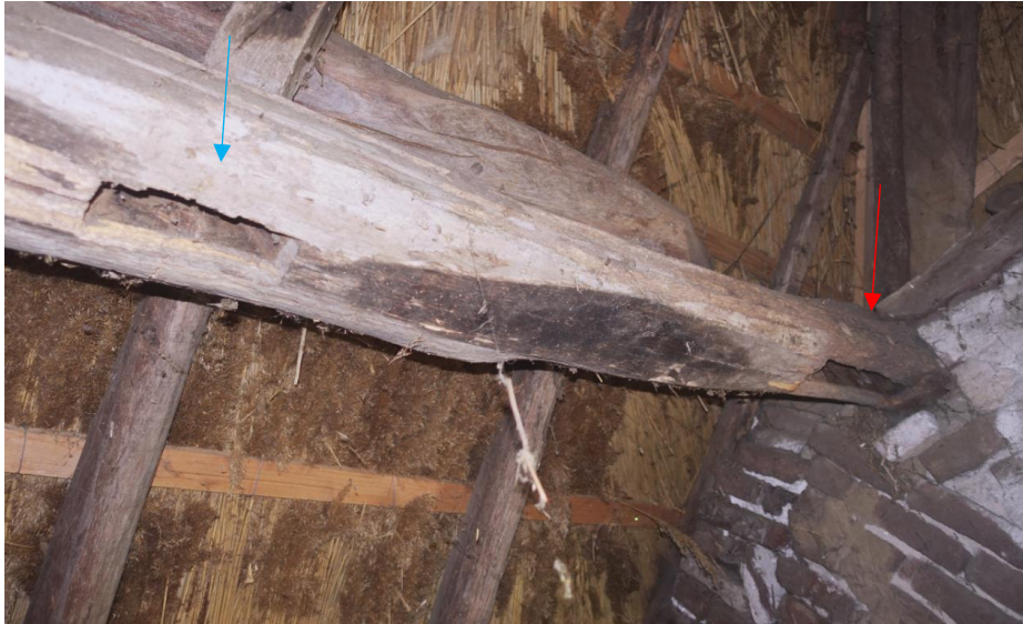
De gebintplaat aan de voorzijde van de boerderij heeft pengaten van een verdwenen stijl (rode pijl) en windschoor (blauwe pijl). De stijl geeft de positie van de oude voorgevel weer.
