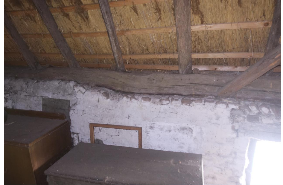
Zicht op de oude strijk balk in de voorgevel met de aansluiting van het muurwerk in rollaag of stroomlaag.
