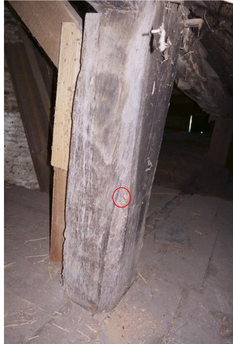
Het monster uit de stijl aan de rechterzijde van het eerste gebint is genomen op zolderhoogte.
