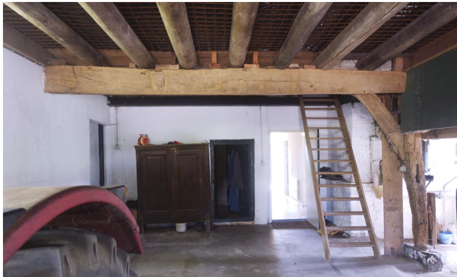
Zicht op het middendeel van de stal met de in 1950 vernieuwde betonnen vloer op de begane grond en zoldervloer van enkelvoudige rondhouten balken.
