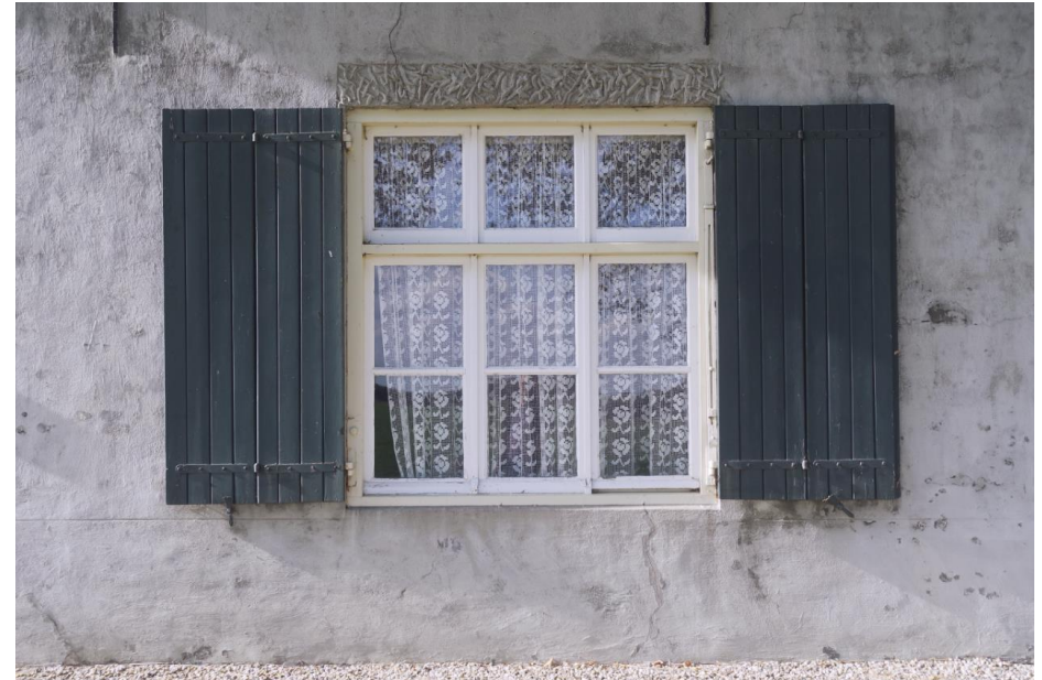
Het grote venster op de begane grond met onder de luiken en aansluitend op de onderdorpel de horizontale streep in het pleisterwerk van de imitatieplint.
