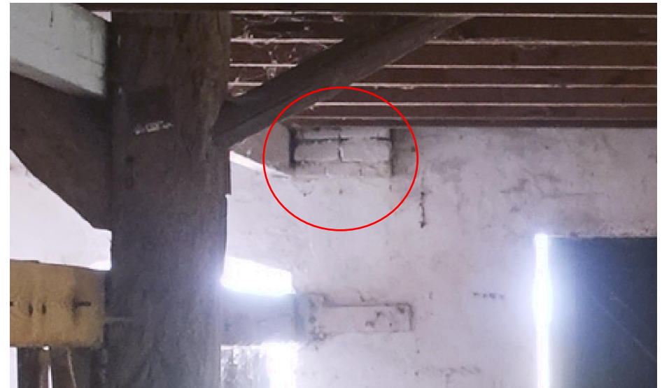
De noordelijke stijl van het achterste gebint in het stalgedeelte is op een bakstenen poer geplaatst na vernieuwing van de gevel in 1950.
