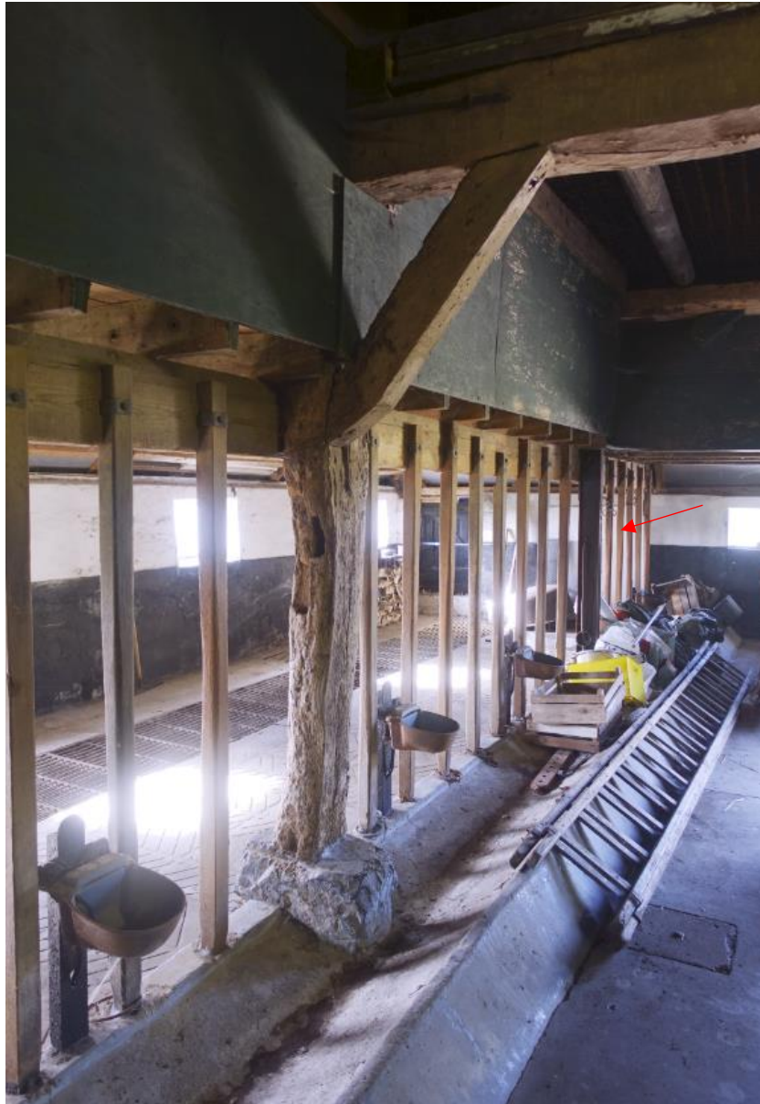
Zicht op de achterste gebinten in het stalgedeelte, met bij de rode pijl de stalen kolom als stijl.
