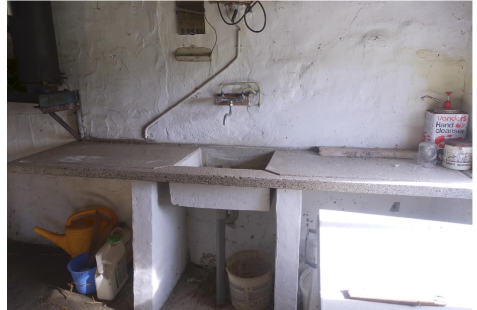
Tegen de achterwand van de badkamer, aan de zuidzijde van het stalgedeelte, is een granito aanrecht aanwezig.
