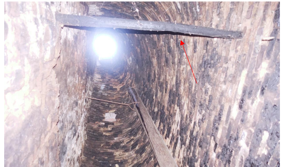
De binnenzijde van het rookkanaal gezien naar boven. Bij de pijl is een oude ijzeren staaf aanwezig waar rookwaar aan werd opgehangen.
