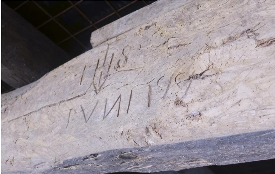
Zicht op de ankerbalk van het derde gebint met de inscriptie IHS PVNL 1773.
