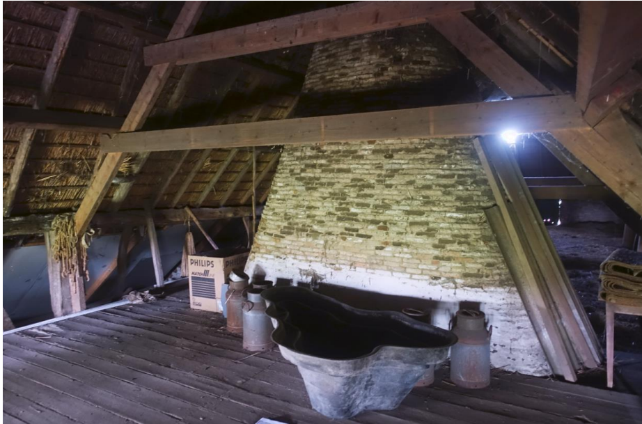
Zicht op het rookkanaal van de voormalige haard, gezien vanaf de zolder boven het woongedeelte.
