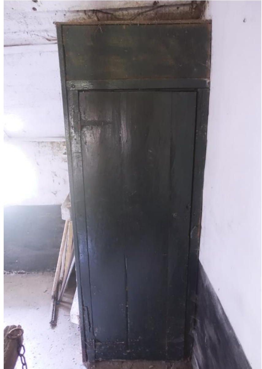
Tegen de noordelijke gevel van het stalgedeelte is een toilet met houten ombouw gesitueerd.
