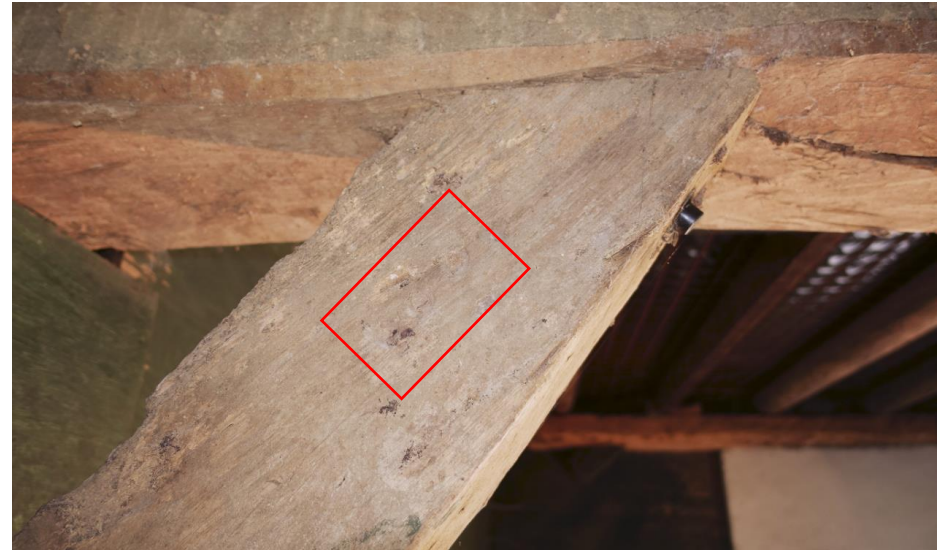
De telmerken op het linkerkorbeel bij het derde gebint.
