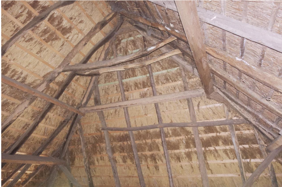
Zicht op de oude sporenparen met hanehouten aan de voorzijde van de boerderij.
