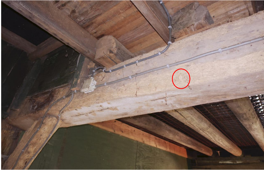
De tweede ankerbalk in de gebintconstructie met bij de rode cirkel het gat waaruit het boormonster is genomen. Deze balk is gedateerd op 1771 +/- 6 jaar.
