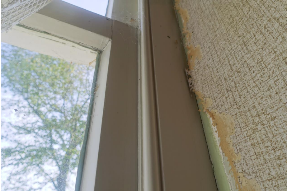
Zicht op de binnenzijde van het noordelijke venster met 4-ruits schuifraam in de voorgevel en peerkraalprofiel.
