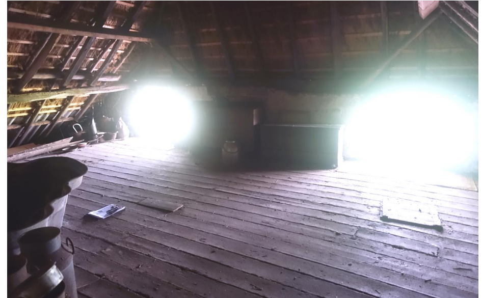
Zicht op de vloerdelen van de zoldervloer boven het middendeel van het woongedeelte.
