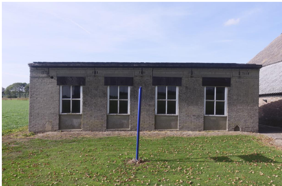
Zicht op de gevel aan de zijde van de Langestraat van de voormalige jongveestal uit 1931.
