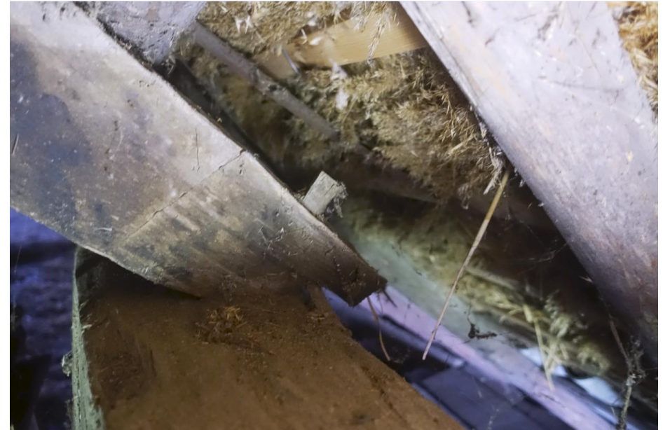
Detail van de met houten pennen bevestigde sporen in de gebintplaat.
