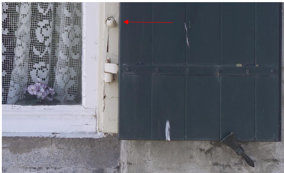
Detail van een luik met bij de rode pijl de ijzeren pen waarmee de ijzeren staaf geborgd wordt waardoor het venster kan worden afgesloten.
