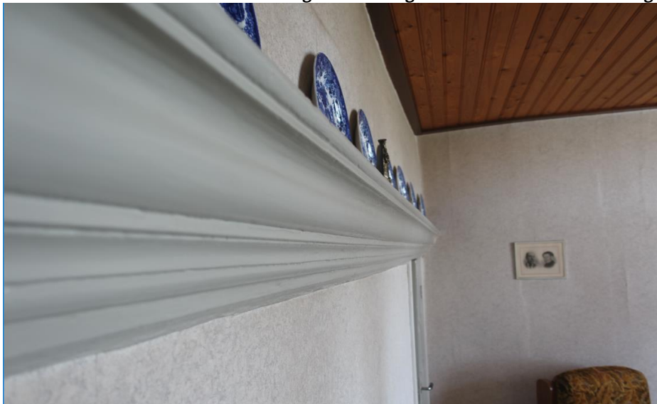
Detail van de boezembalk, die gezien de profilering uit de achttiende eeuw kan stammen.
