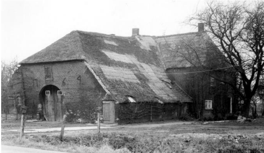
Zicht op de boerderij aan de Achterstraat 6 op een foto van voor de restauratie in de jaren '70 van de vorige eeuw. HLVR beeldbank, nr. 01075.
