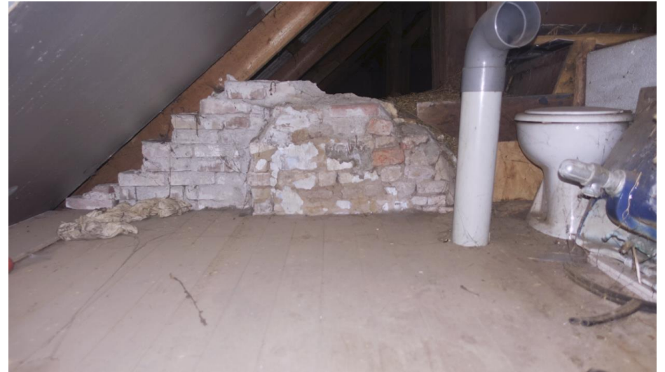
Op zolder is een deel van het oude metselwerk van de achterwand van de huidige badkamer zichtbaar. Deze ruimte behoort tot een oudere opzet.
