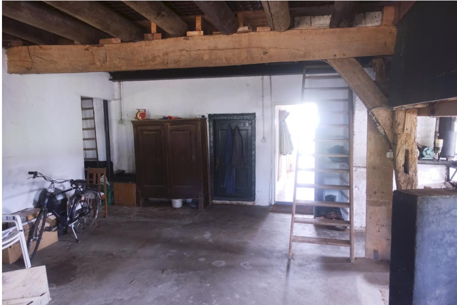
De middenbeuk van het stalgedeelte gezien in de richting van de voorgevel, met achter het gebint de houten steektrap naar de zolder.
