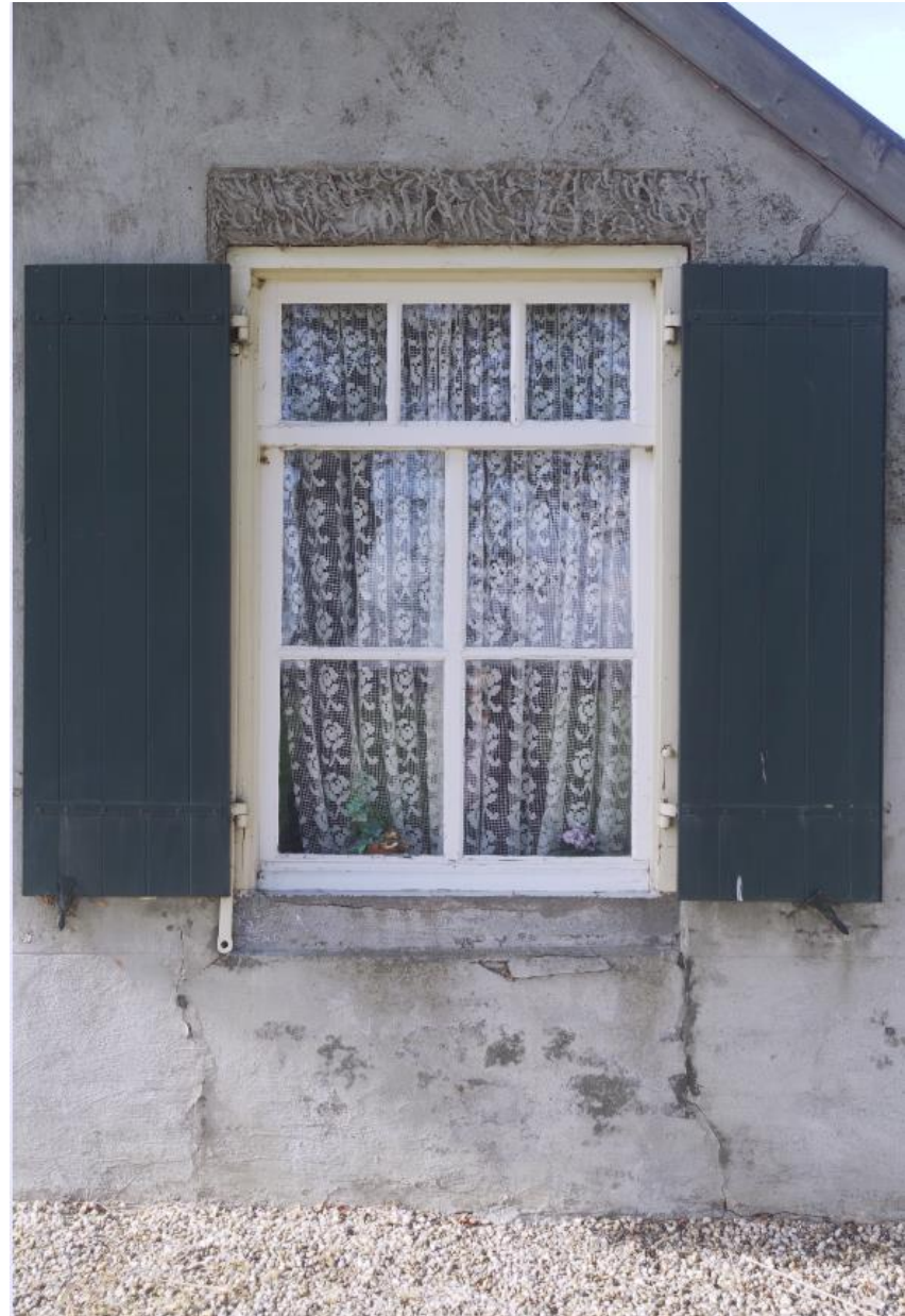
Zicht op het venster met ouder kozijn, aan de noordzijde van de voorgevel.
