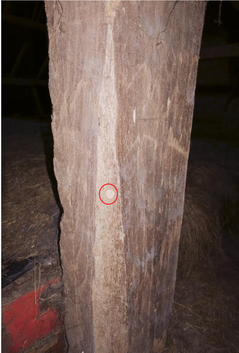
De linker stijl van het derde gebint is ook vanaf de zolder bemonsterd.
