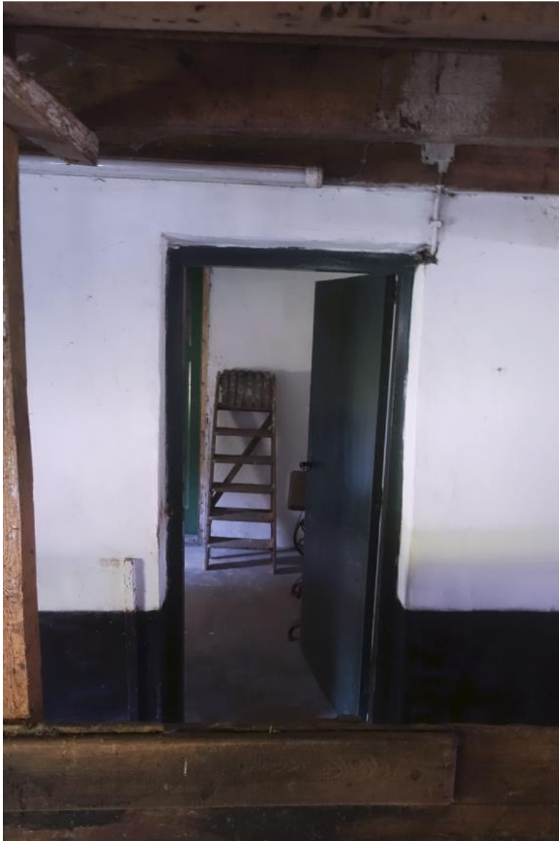
De doorgang naar de voormalige melkkamer aan de achterzijde van het woongedeelte, gezien vanuit de noordelijke zijbeuk in het stalgedeelte.
