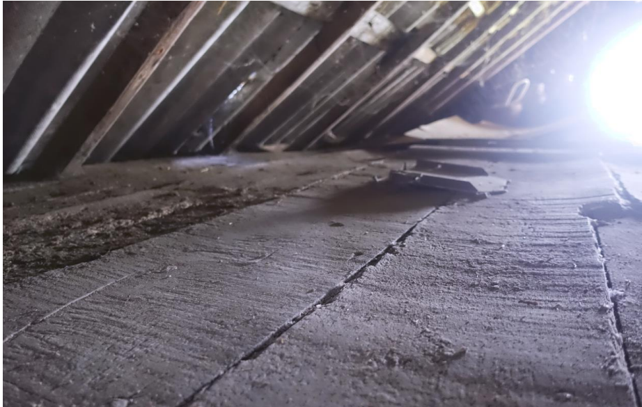
Detail van de zaaglijnen op de oude eikenhouten vloerdelen van de zoldervloer boven de noordelijke zijbeuk.
