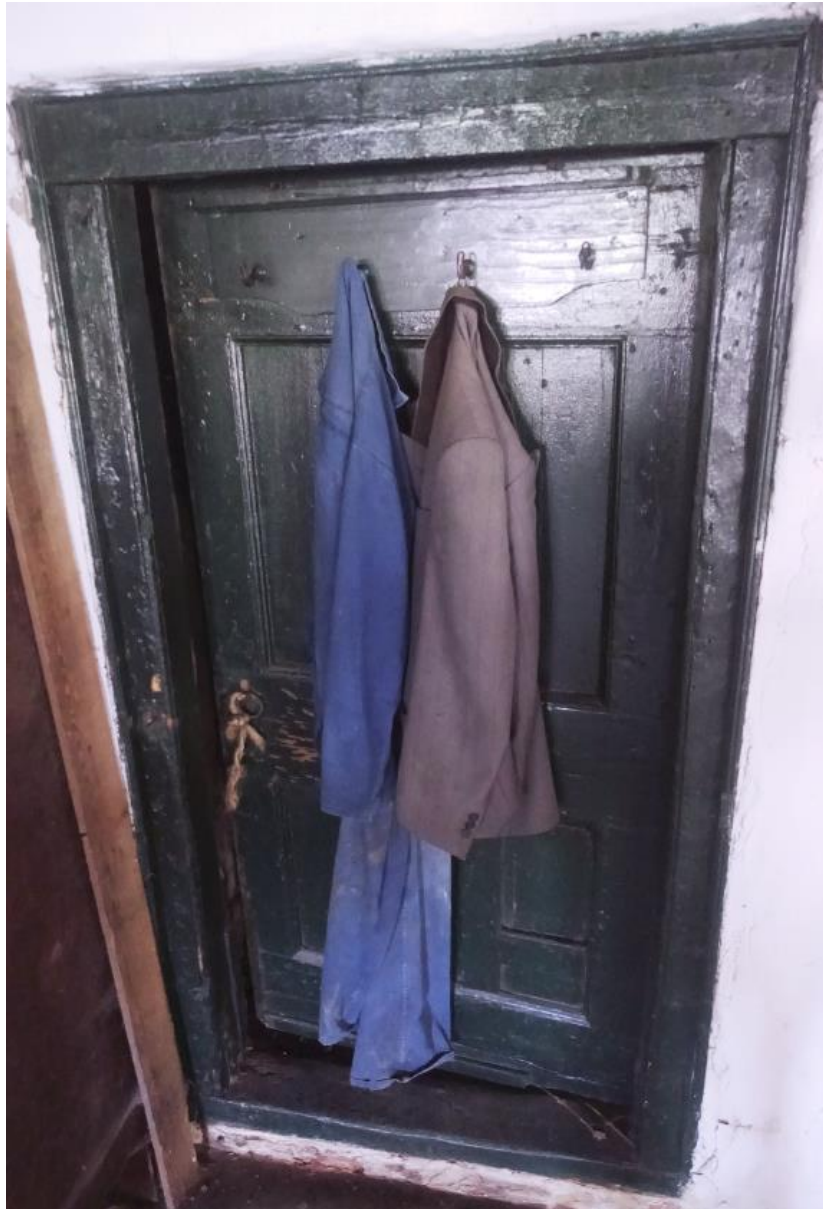
De doorgang naar de binnenzijde van het rookkanaal is ingezet met een paneeldeur en deurkozijn uit de achttiende eeuw.
