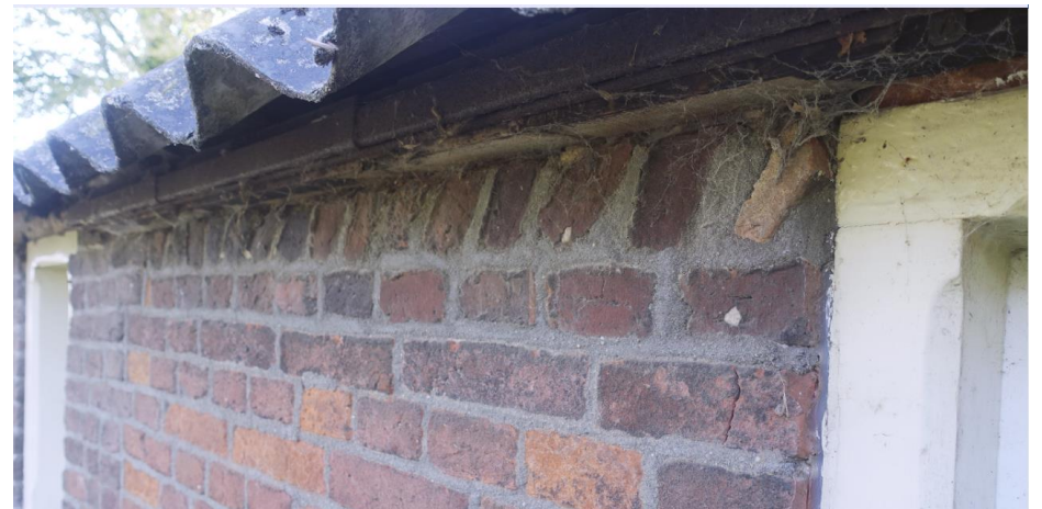
Detail van de rails van de schuifdeur die in 1979 verwijderd is.
