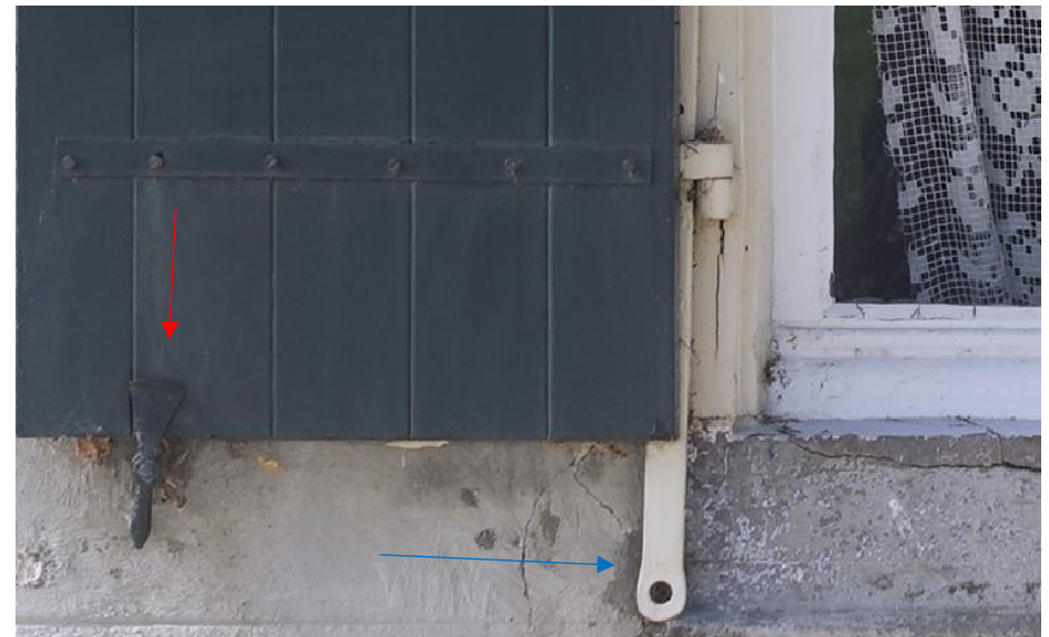
Detail van een vensterluik met bij de rode pijl de luikwervel en bij de blauwe pijl de luiksluiting in de vorm van een ijzeren staaf.
